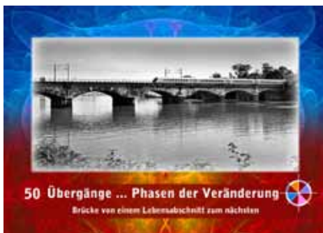
Eisenbahnbrücke über den Neckar bei Ladenburg
