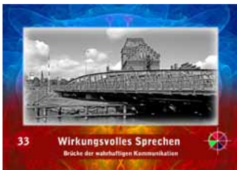
Drehbrücke im Hafen Lübeck
