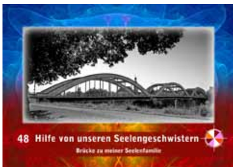
Neckarbrücke bei Mannheim-Seckenheim Am Heumarkt
