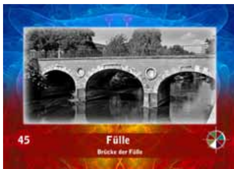
Leinebrücke Am Marstall in Hannover
