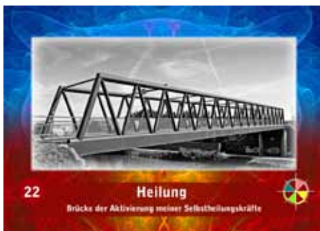
Mittellandkanalbrücke zum Allerpark bei Wolfsburg
