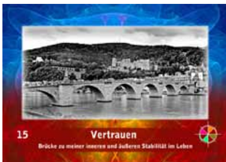
Neckarbrücke in Heidelberg
